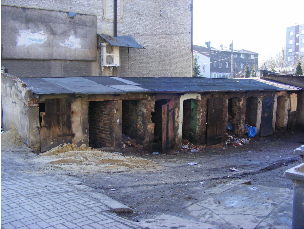
Widok frontu budynku
